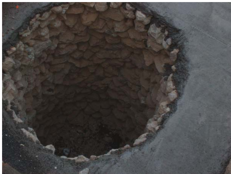
Pozo filtrante tradicional.
