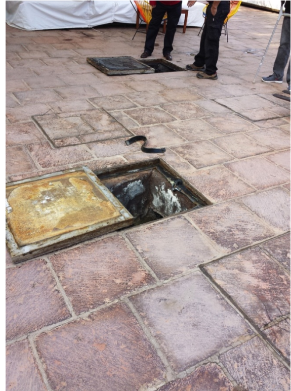
5. Detalle arquetas abiertas fosas sépticas 1
