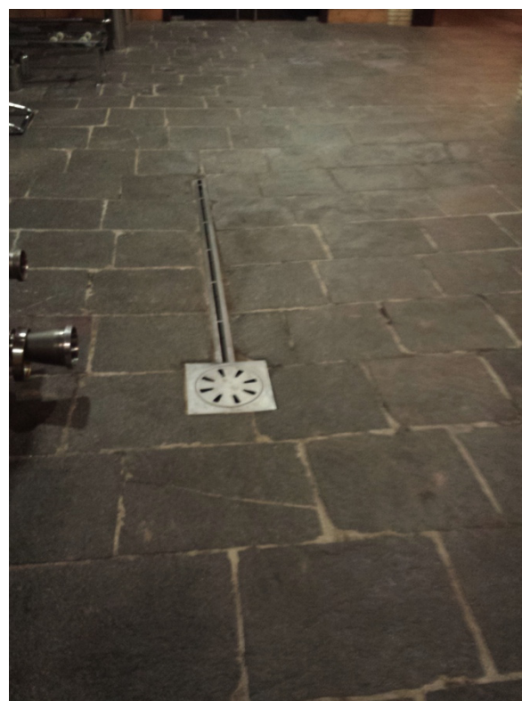
15. Detalle canal de drenaje y sumidero en planta baja en zona lateral, edificio principal 1
