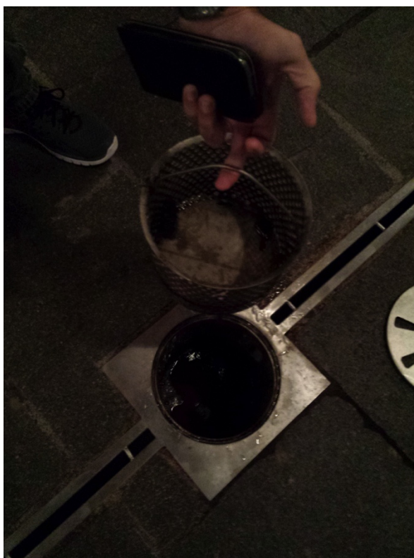
10. Detalle sumidero con tamiz para retención de sólidos en planta baja en zona central en edificio principal 2
