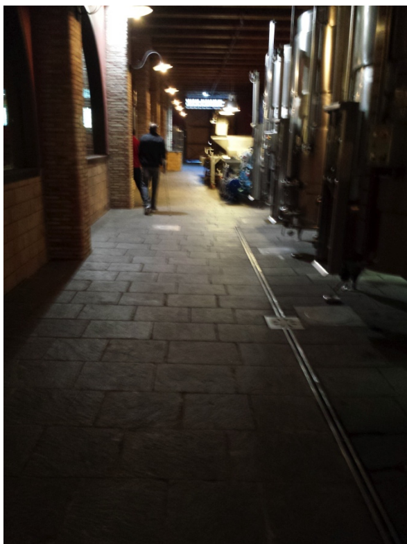
16. Detalle canal de drenaje planta alta en zona recepción y proceso uva, edificio principal 1
