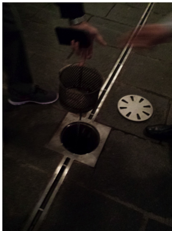
9. Detalle sumidero con tamiz para retención de sólidos en planta baja en zona central edificio principal 1
