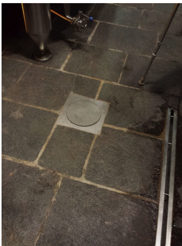
14. Detalle desagüe para limpieza de depósitos en zona lateral
