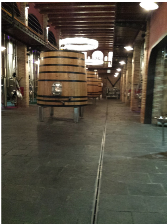
8. Detalle canal de drenaje planta baja en zona central en edificio principal 2
