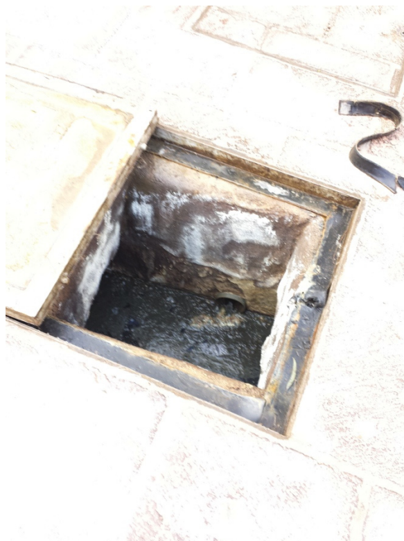
6. Detalle arqueta abierta fosa séptica
