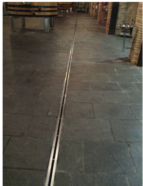
7. Detalle canal de drenaje planta baja en zona central en edificio principal1
