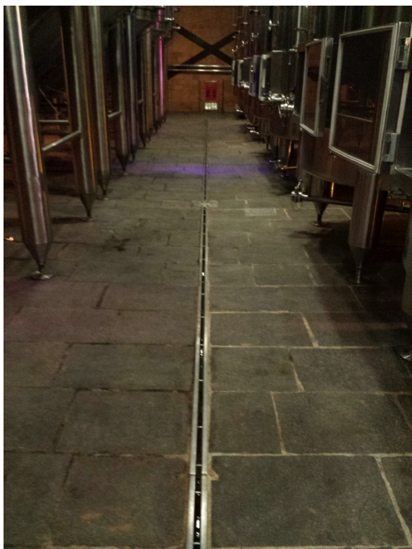
12. Detalle canal de drenaje planta baja en zona lateral en edificio principal 1
