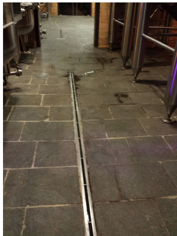
13. Detalle canal de drenaje planta baja en zona lateral en edificio principal 2
